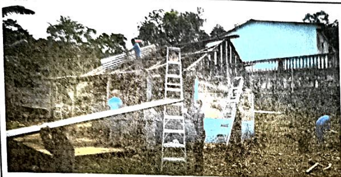
Foto1: ELIMINACION DEL TECHO DE LA COCINA DEL ESTABLECIMIENTO.
