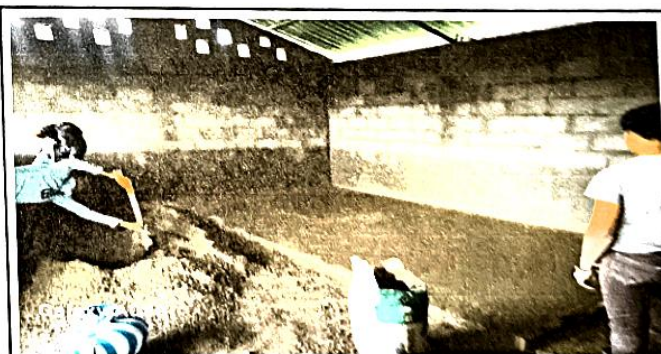
Foto 6: COLOCACION DE PISO DE CEMENTO EN LA COCINA DEL CENTRO EDUCATIVO
