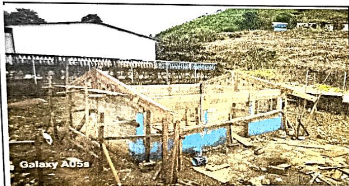
Foto3: COLOCACION DE BLOCKS EN SUSTITUCION DE MADERA DE LA COCINA DEL CENTRO EDUCATIVO.
