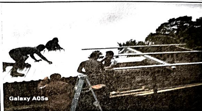
Foto 2: COLOCACION DEL TECHO DE LA COCINA DEL CENTRO EDUCATIVO.
